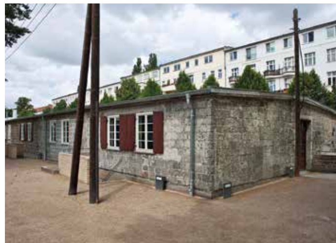
» Ubikace č. 13 – místo nové výstavy, © Dokumentační centrum nucené práce Berlín
